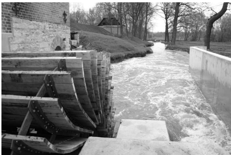
Unterschlächtiges Wasserrad der Ölmühle Eberstedt
