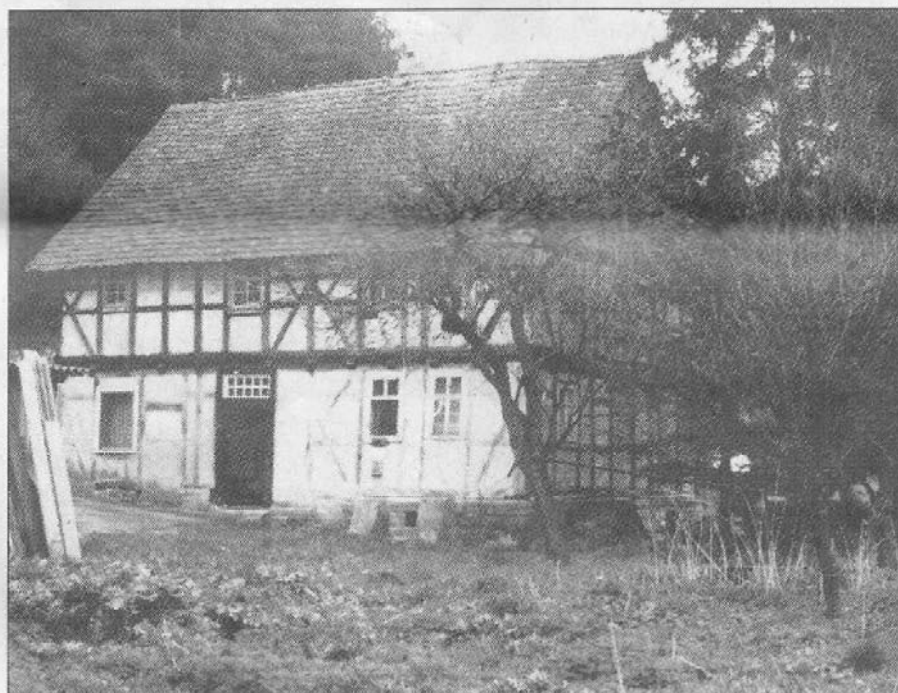
Das Fachwerk an der Eingangsseite der Mäusemühle hat der neue Besitzer komplett ausgetauscht.
